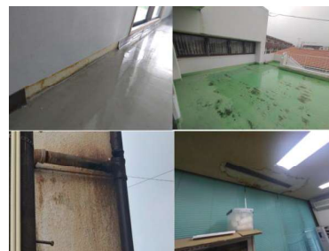
改修予定箇所
