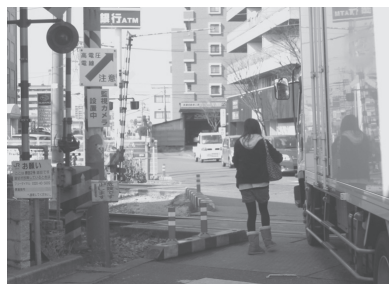
改良工事が待たれる原田2号踏切
