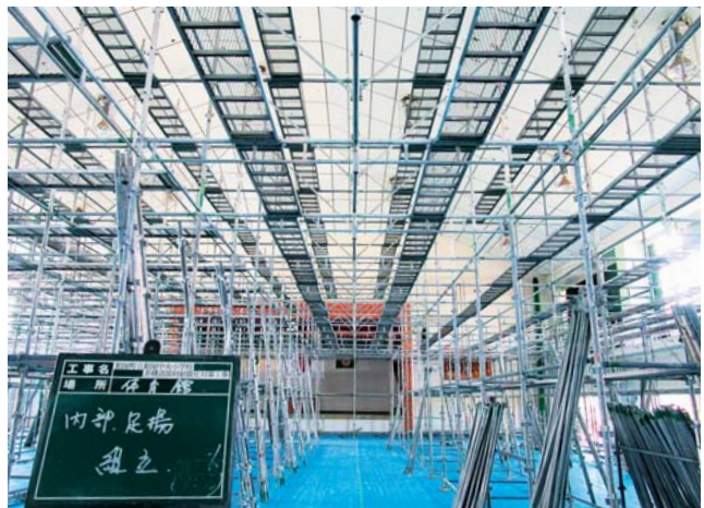
町内小学校の耐震化対策工事
