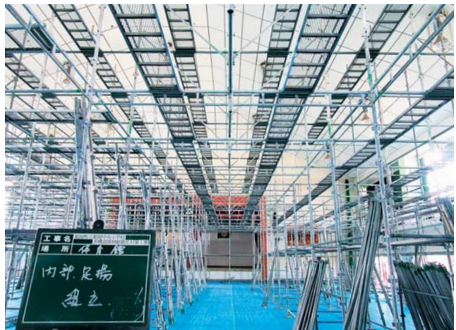
町内小学校の耐震化対策工事
