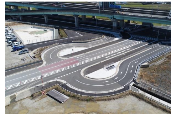
峰屋敷・向川原線道路新設工事
