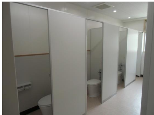
小中学校トイレ大規模改造工事
