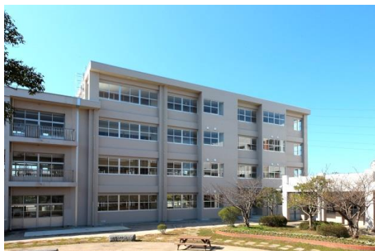
粕屋東中学校校舎増築工事
