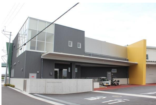
学校給食共同調理場建設工事
