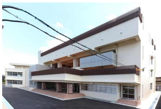
仲原小学校増築工事
