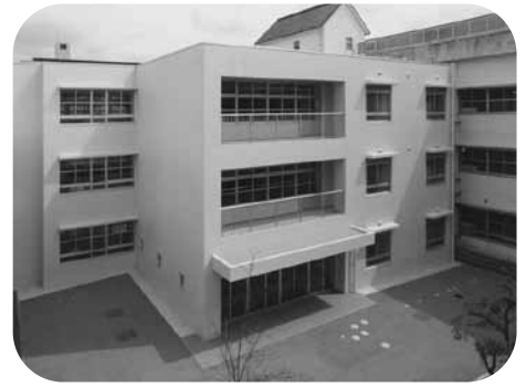
粕屋中央小学校増築工事
