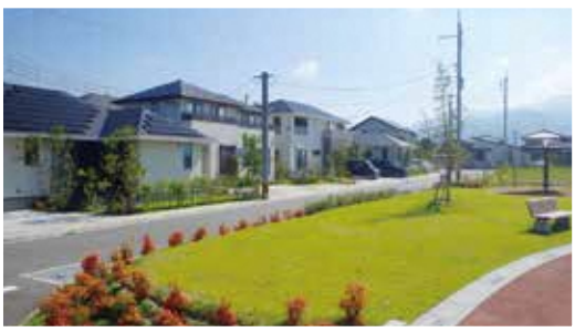
平成30年度から支援する酒殿駅南土地区画整理事業の第1期工事が完成しました。
