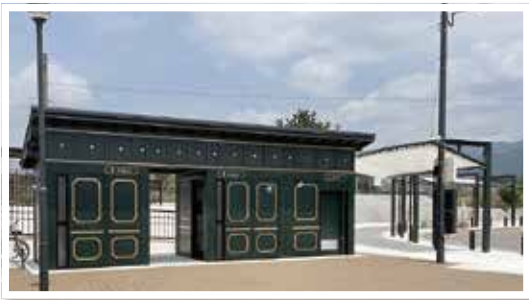
JR酒殿駅南口に、公衆トイレ、駐輪場、シェルターなどを整備しました。
