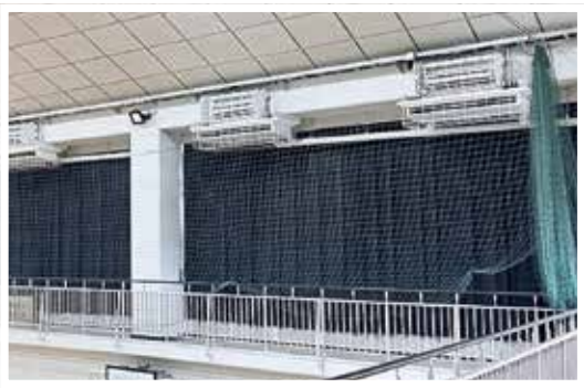
町内小中学校の体育館に空調設備を設置しました。
