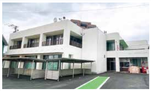
袖須文化センターの長寿命化工事を実施しました。
