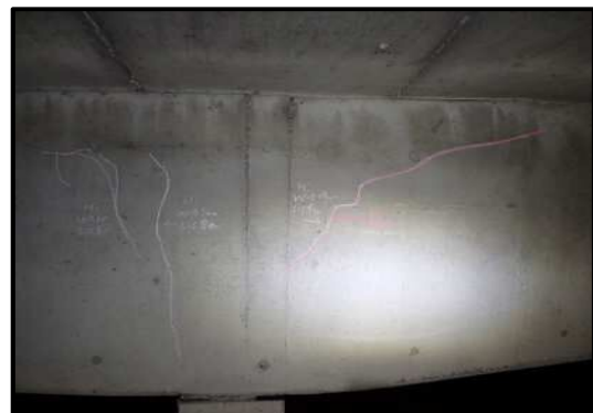
[ 駕与丁跨道橋 上部構造（主桁測面：ひびわれ） ]
