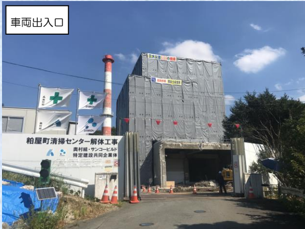
重機エントランス（養生設備）
