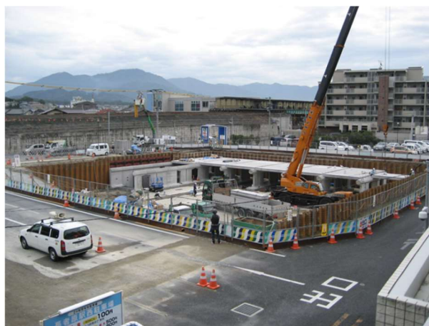
粕屋フォーラム駐車場内雨水調整池築造工事(平成 23 年)
