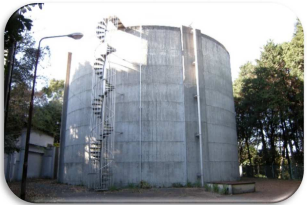
第2(西尾山)配水池
