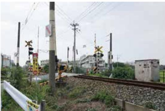
K. <鉄道>踏切保安装置/軌道/電柱/防護柵/設備箱
