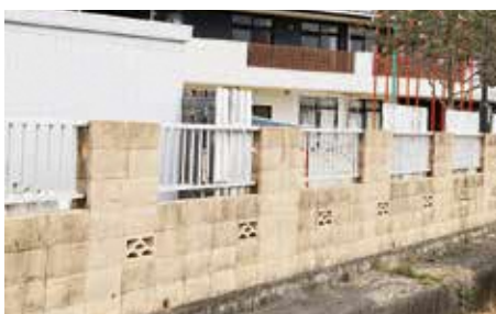
大川保育園ブロック塀改修
