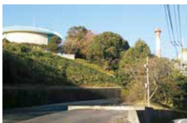
解体が待たれるゴミ焼却場
