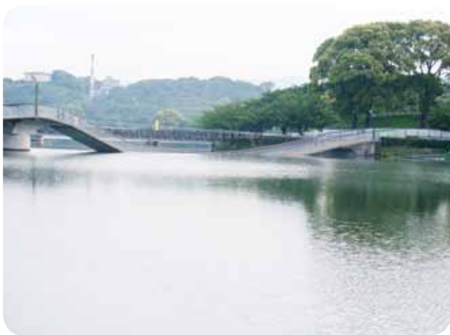
水鳥橋の落橋の様子
